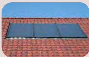
Intégrés à la toiture
